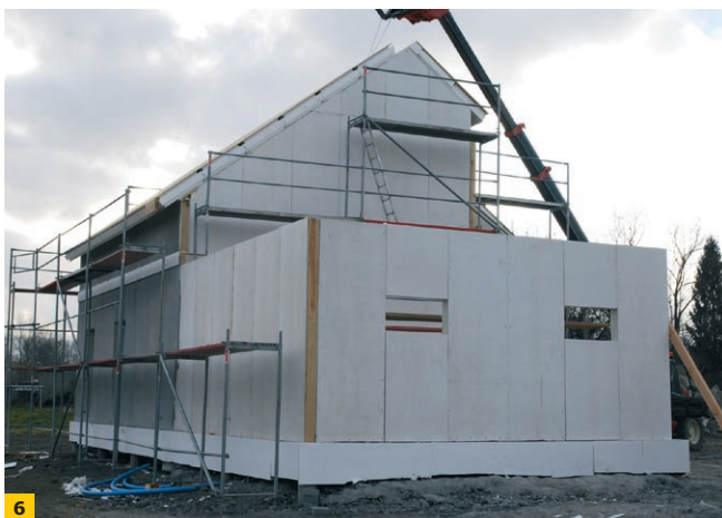
FOT. 4-7. Etapy wykonania domu modelowego w technologii SIP
