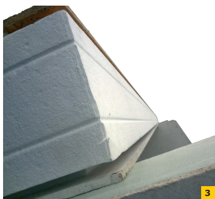
FOT. 1–3. Panel SIP – kompozytowa płyta warstwowa
