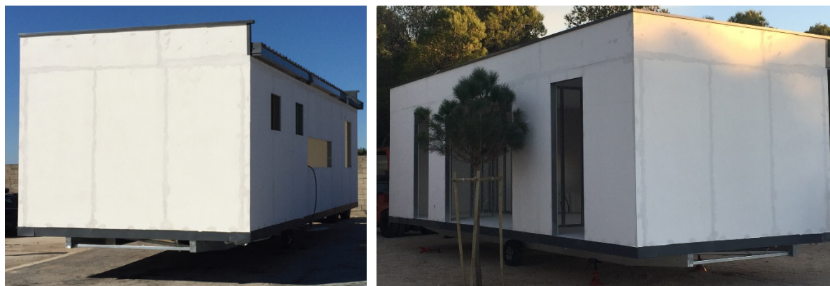
Rys. 4: Przykładowy kompozytowy moduł przestrzenny w stanie surowym otwartym
